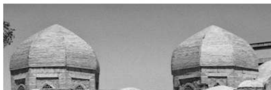
c) Mog'aqi Attor masjidi XII asrda Qoraxoniylar hukmronligi davrida bunyod etilgan. Buxoro. Asosi muntazam sakkiz burchakli sferokonik gumbaz.
