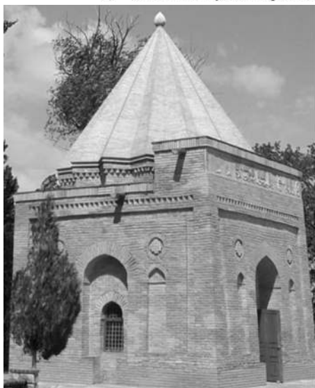
m) Boboji Xotun maqbarasi asosi o'n olti burchakli yulduz shaklidagi umumiy uchga ega piramidasimon gumbaz. Jambul viloyati XI asr.
