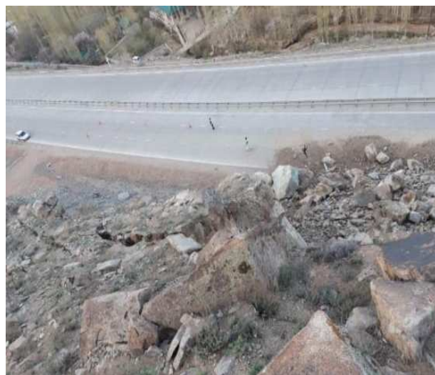
2-rasm. A-373 "Toshkent-O'sh" avtomobil yo'lidagi tog' ko'chkisining avtomobil yo'liga ta'siri: a-oquvchan gruntning ko'chishi; b-magmatik tog' jinslarining ko'chishi.
