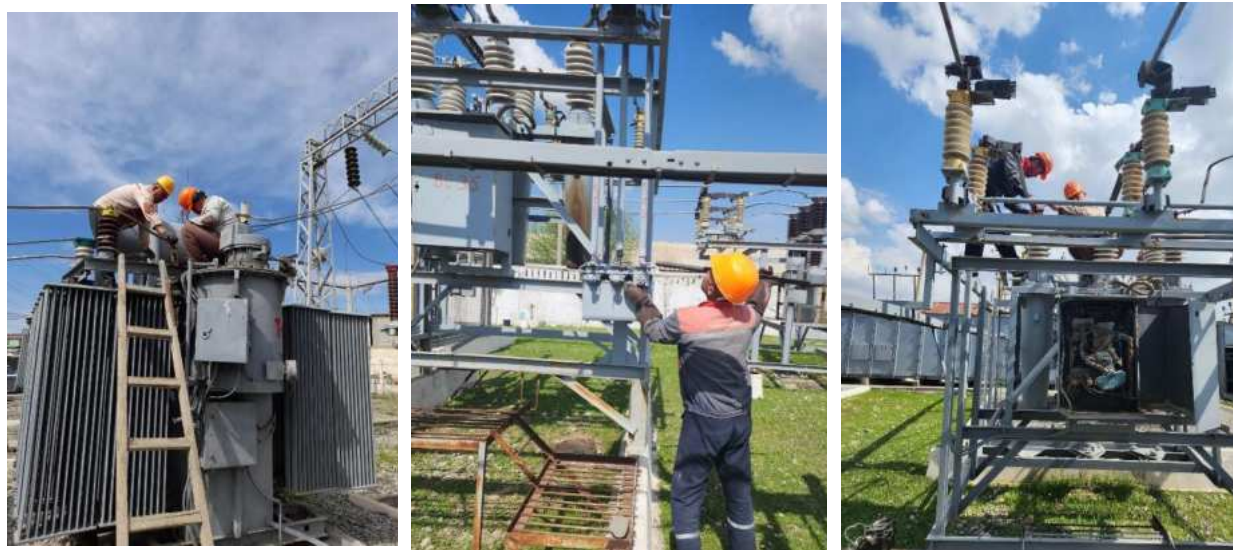
1-rasm. 35/10 kV li kuch transformatori qurilmalari hamda releli himoyasi va avtomatikasini tekshirish sinov ishlari
