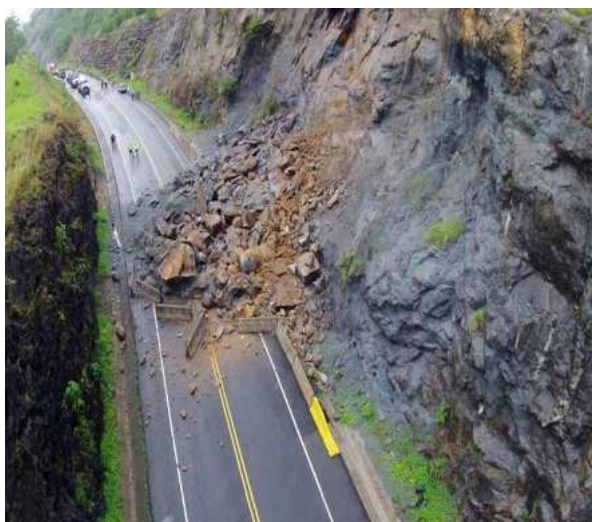
2-rasm. A-373 "Toshkent-O'sh" avtomobil yo'lidagi tog' ko'chkisining avtomobil yo'liga ta'siri: a-oquvchan gruntning ko'chishi; b-magmatik tog' jinslarining ko'chishi.
